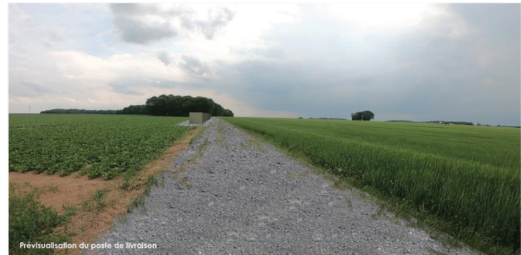
Figure 75 : Prévisualisation du poste de livraison de la Ferme éolienne du Champ Personnette (Source : Epure Paysage)
