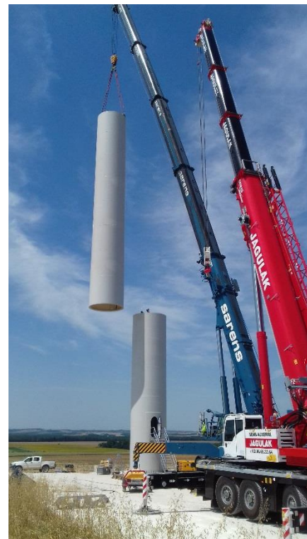
Figure 54 : Montage de la première section du mât (Source : VOLKSWIND)
