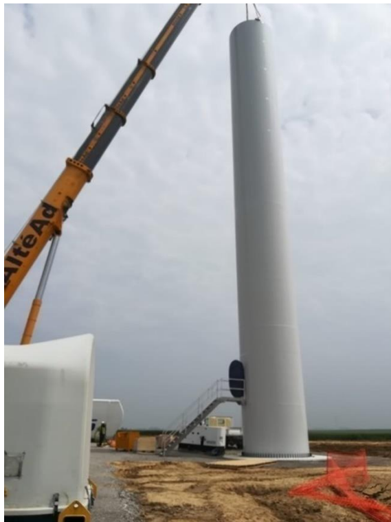
Figure 54 : Montage de la première section du mât (Source : VOLKSWIND)
