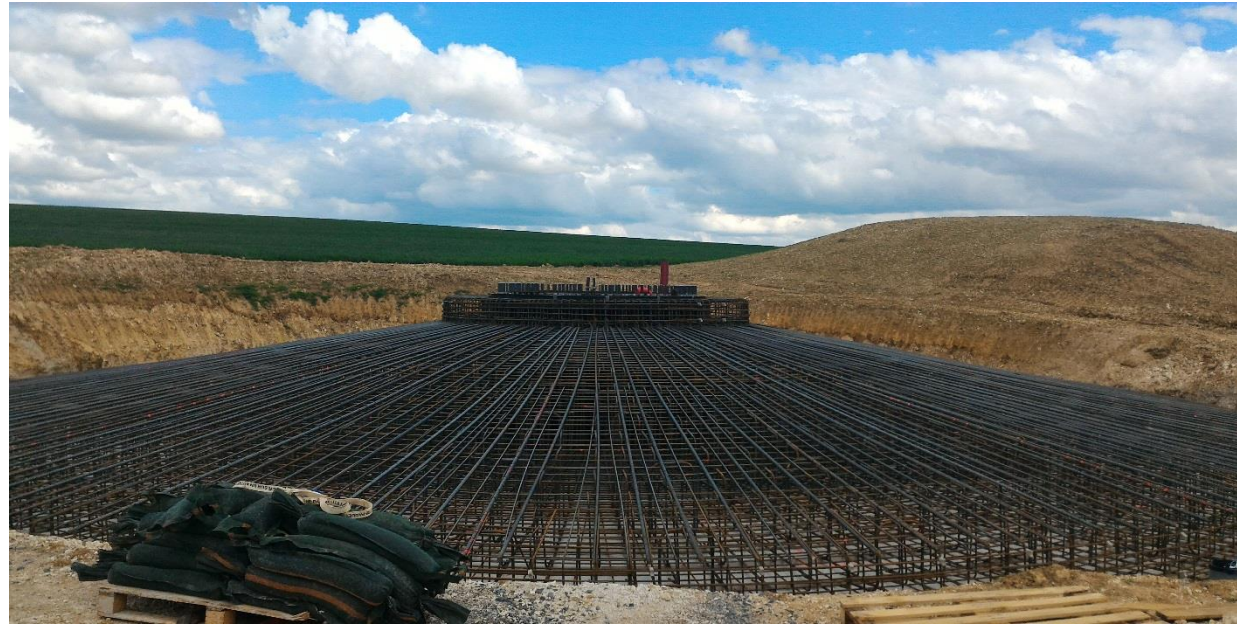
Figure 48 : Ferrailage du massif
