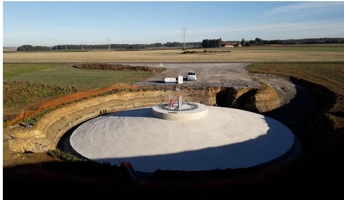
Figure 49 : Fondation après coulage béton
