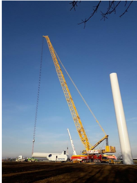
Figure 50 : Grue permettant l'assemblage des différents éléments d'une éolienne
