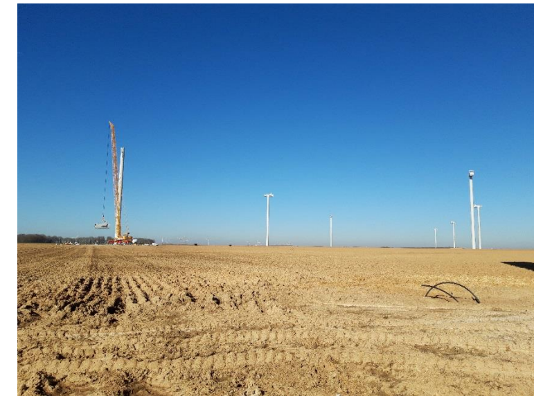
Figure 59 : Un parc de neuf éoliennes Vestas V112 en construction (Source : VOLKSWIND)
